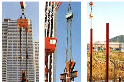
그림 2. 기존 개발된 오토 샤클을 이용한 시공 장면
