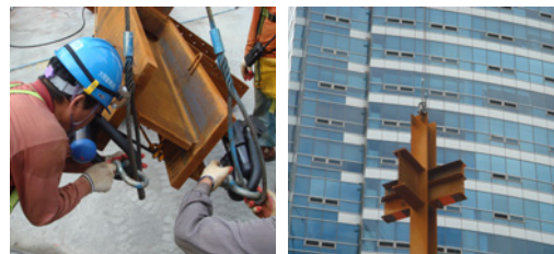
그림 11. 구현된 오토 샤클을 이용하여 작업하는 모습
