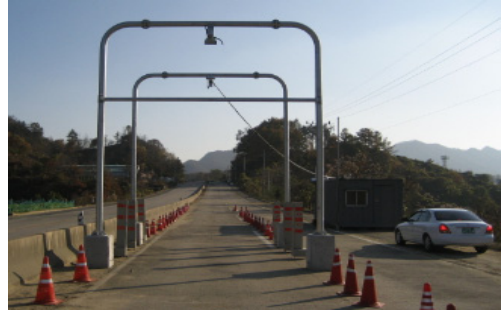
그림 6. ETC 서비스를 위한 시험용 겐트리
