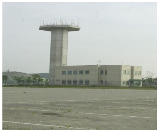
그림 3. 송신소 사이트 Fig. 3. Tx Site
