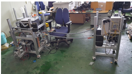
그림 13. 저체온 유도장비 부하 테스트 Fig. 13. Hypothermia Induction Equipment Load Test)
