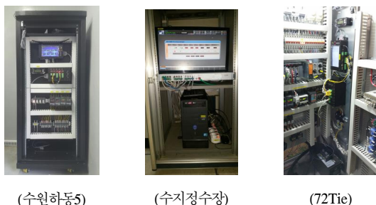
그림 19. 현장 실증시험 설치 사진 Fig. 19. Field demonstration test installation view
