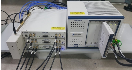
그림 8. 테스트베드 기기 Fig. 8. Testbed equipments
