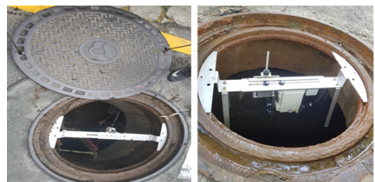
그림 2. 길이 조정 거치 프레임의 구조 Fig. 2. Structure of Adjustable Length Mounting Frame
