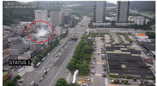
그림 4. 고층 광역 CCTV로 촬영한 화재 현장 Fig. 4. Fire scene filmed by high-rise wide-angle CCTV
